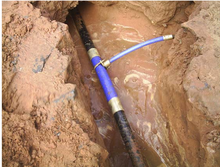
Foto N° 9: Cañería reparada sobre suelo saturado. Orden de Servicio N° 581063
