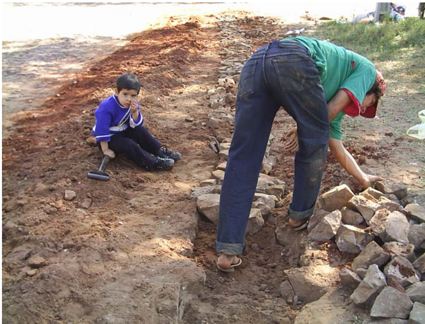
Foto N° 13: Asentamiento de empedrado, sin colchón de arena. Orden de Servicio N° 589859
