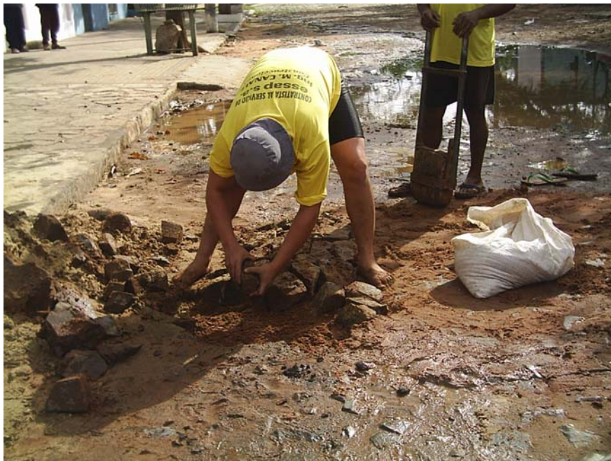
Foto N° 13: Asentamiento de empedrado, sin colchón de arena. Orden de Servicio N° 589859
