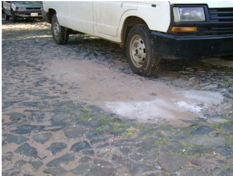
Foto N° 3: Pavimento hundido por compactación inadecuada.
