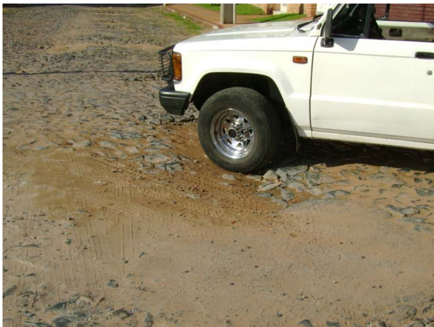
Foto N° 3: Pavimento hundido por compactación inadecuada.
