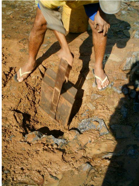
Foto N° 11: Sistema de compactación adoptado. Orden de Servicio N° 589859
