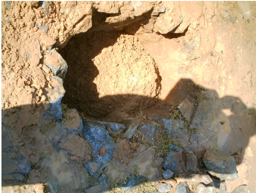
Foto N° 7: Relleno con suelo saturado. Orden de Servicio N° 581063
