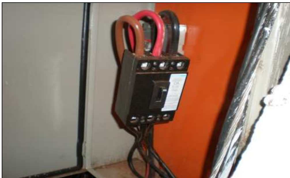
Foto N° 14 Llave termo magnética sin sujeción
