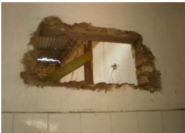
Foto N° 2 Abertura de SS.HH. sexado sin terminar
