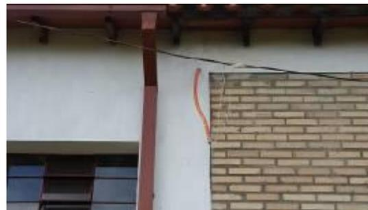
Empalmes y derivaciones de conductores sin cajas de conexión.
