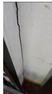
Deterioro del muro. Se observó una grieta importante entre el muro construido y el pilar existente, donde se ubica el portón metálico corredizo, que produce el desprendimiento del mismo. Se sugirió al Director de la institución tomar las medidas correspondientes para subsanar el problema.
