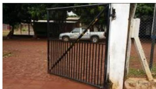
Portón metálico reparado. Faltan trabajos para terminación de la colocación del portón, está sin macizar, revocar y pintar en los sectores de sujeción con el pilar.
