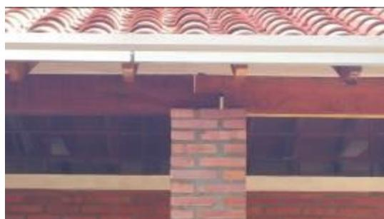
Insuficiente encastre, ni sujeción entre las piezas de vigas de madera de la galería.
