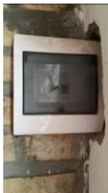
Tablero eléctrico de plástico, no cumple con las EETT., incorrectamente colocado, dificultad en su acceso, que a la vez implicó daños a la mampostería y revoque.
