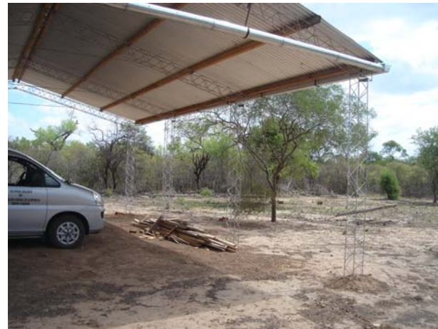
Estructura metálica con correas de madera
