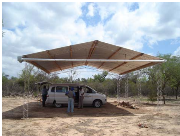
Cobertura metálica sin cerramiento
