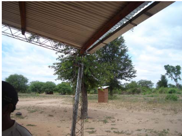
Estructura metálica con caño de desoldado
