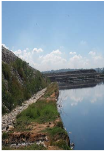
LAGUNA DE LIXIVIADOS
