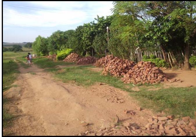
Documento gráfico del empedrado de la calle Santa Clara casi Fulgencio Yegros, donde se observa un tramo de la calle aún sin pavimentar, con el acopio correspondiente de los materiales a ser utilizados y la falta de confinamiento de las piedras en el final del tramo, por lo que las mismas se van desprendiendo.
