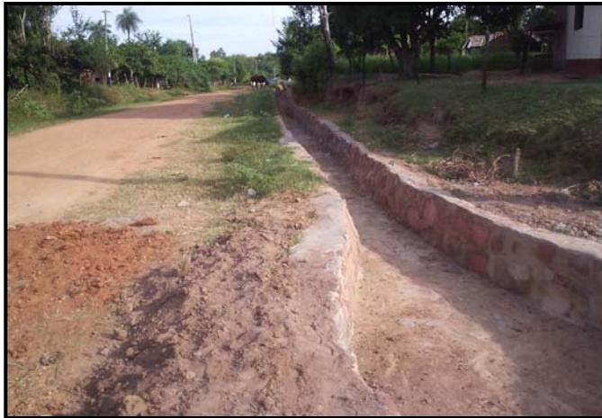
La falta de implementación de un guarda ruedas para proteger a los vehículos, en la unión entre el coronamiento canal de drenaje y la calzada de circulación, ya que ambos se encuentran prácticamente a un mismo nivel; por lo que con lluvia o escasa visibilidad se pueden producir accidentes vehiculares o peatonales, por la dificultad para diferenciar ambos sectores (ver foto izquierda).
