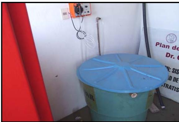
Estado en que se encuentra el equipo de cloración del sistema de abastecimiento de agua de la Compañía San Antonio – Paracau del Distrito de Santa María, donde se observa el tanque de agua sin la conexión correspondiente.
