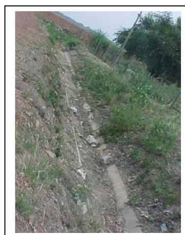
Las obras no cuentan con mantenimiento. Presenta canales con sedimentos y presa de basuras en boca de alcantarillas y celular.
