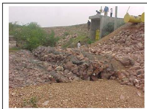
Colchones Reno con deslizamiento por descarga
