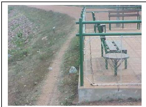
Muro de Glorietas en Muro Norte presenta grietas por aparente colapso de su estructura expuesta al talud.
