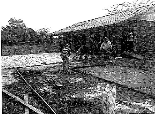
Relleno y compactación de tierra de piso para patio de formación.
