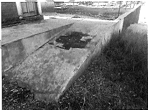
Rampa al costado de sanitario de 1.30m x 3.50m. escuela de 1.20mx2.50m
