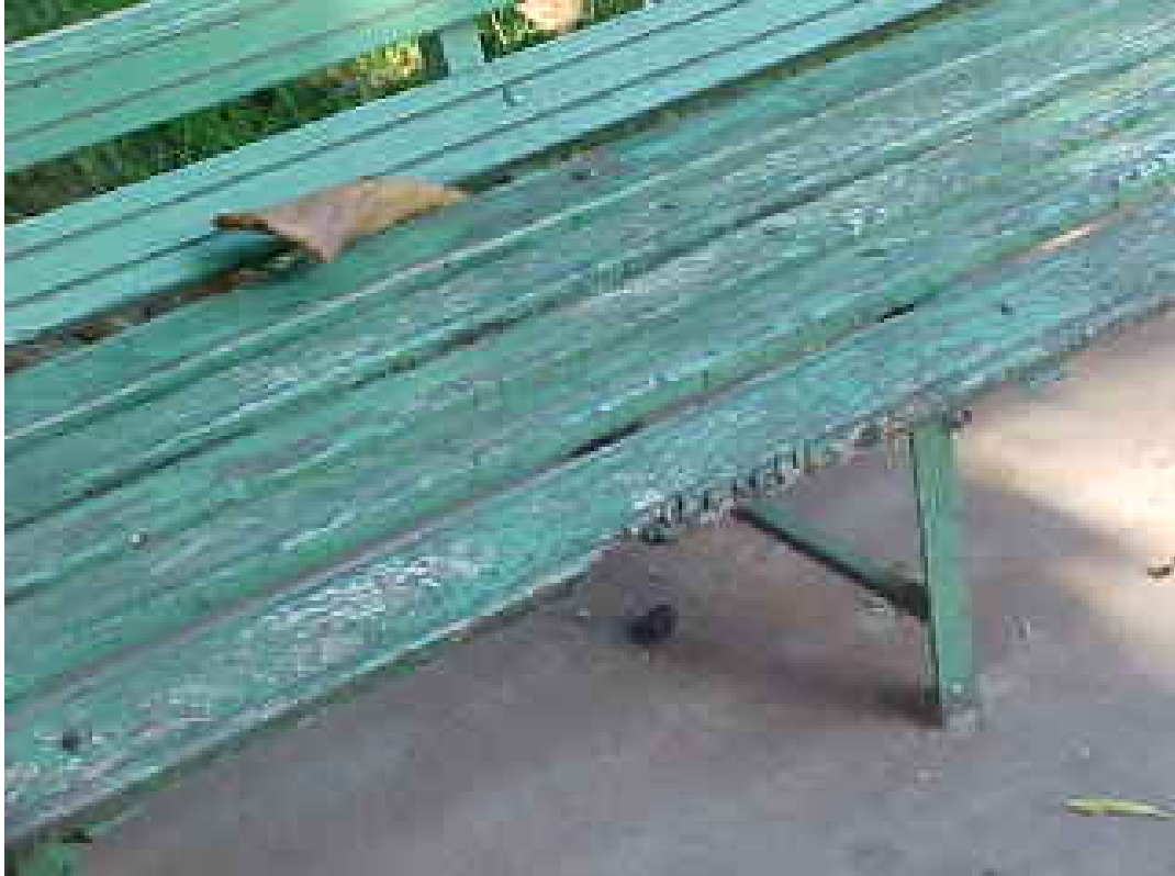
FOTO N° 6: Plaza Alicia Lynch. Bancos viejos recuperados. Se observa que algunas maderas fueron reemplazadas y otras se encuentran carcomidas.
