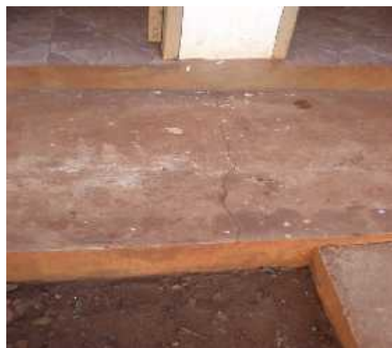
Las guardas presenta resquebrajaduras en el perímetro de la SS.HH.
