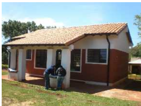
Vista de Obra s recepción definitiva y sin finiquito de pagos.
