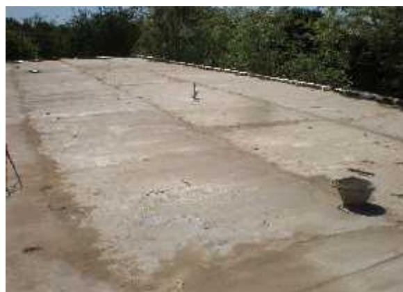
Trabajos de aislacion de techo paralizada.
