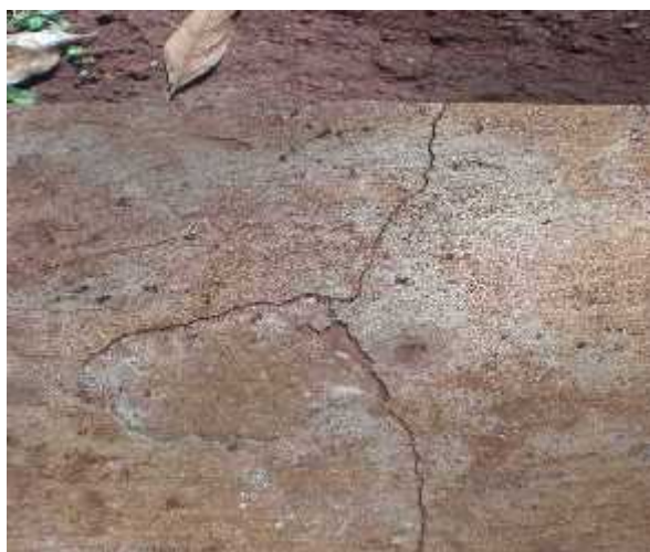
Las guardas presenta resquebrajaduras en el perímetro de la SS.HH.
