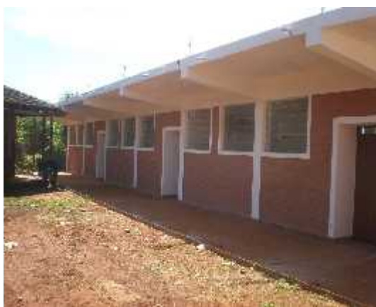
- Vista de Escuela Virgen de Caacupe en etapa de finalización.
