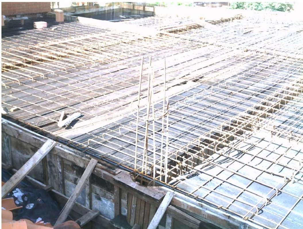
FOTO N° 9: detalle de armaduras de la losa del techo del tercer nivel.
