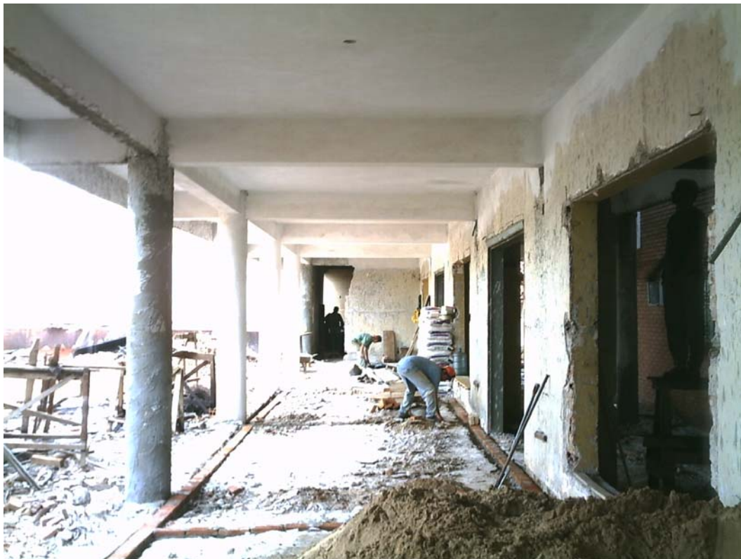
FOTO N° 7: trabajos de revoque de paredes y cielorraso en planta baja.
