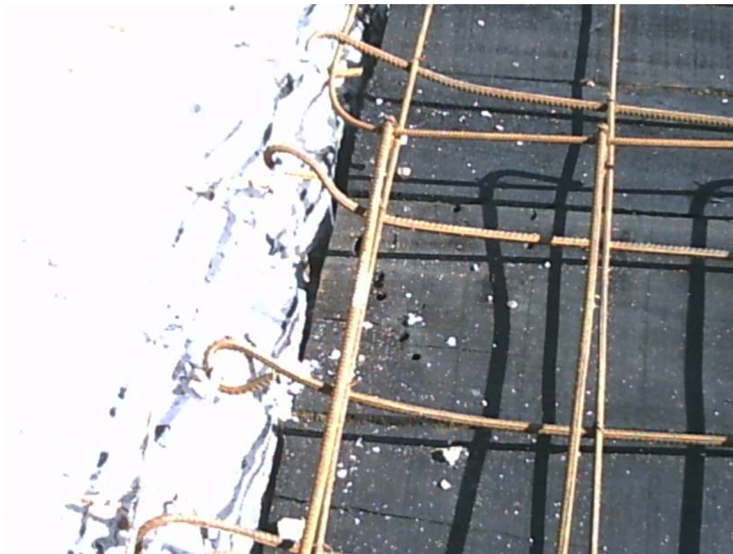
FOTO N° 10: detalle de anclaje de losa nueva con la losa existente en el 2° nivel.
