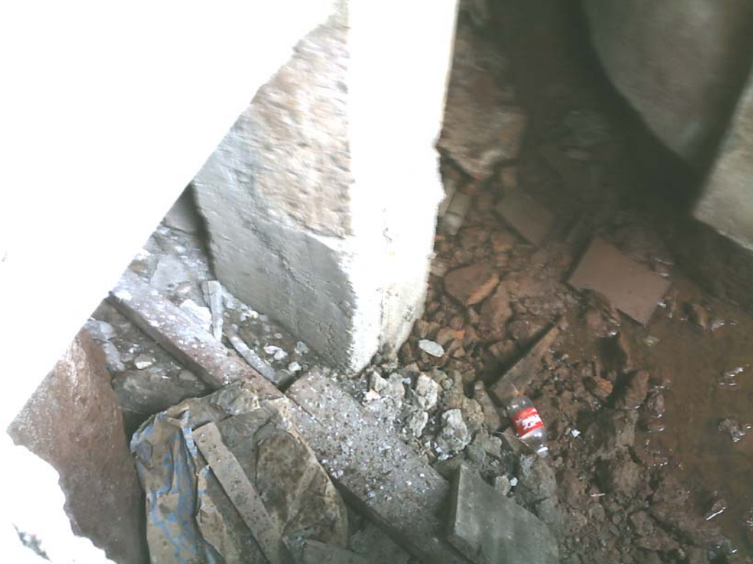
FOTO N° 3: detalle de fuste de prolongación de pilar en el sector de Subsuelo.
