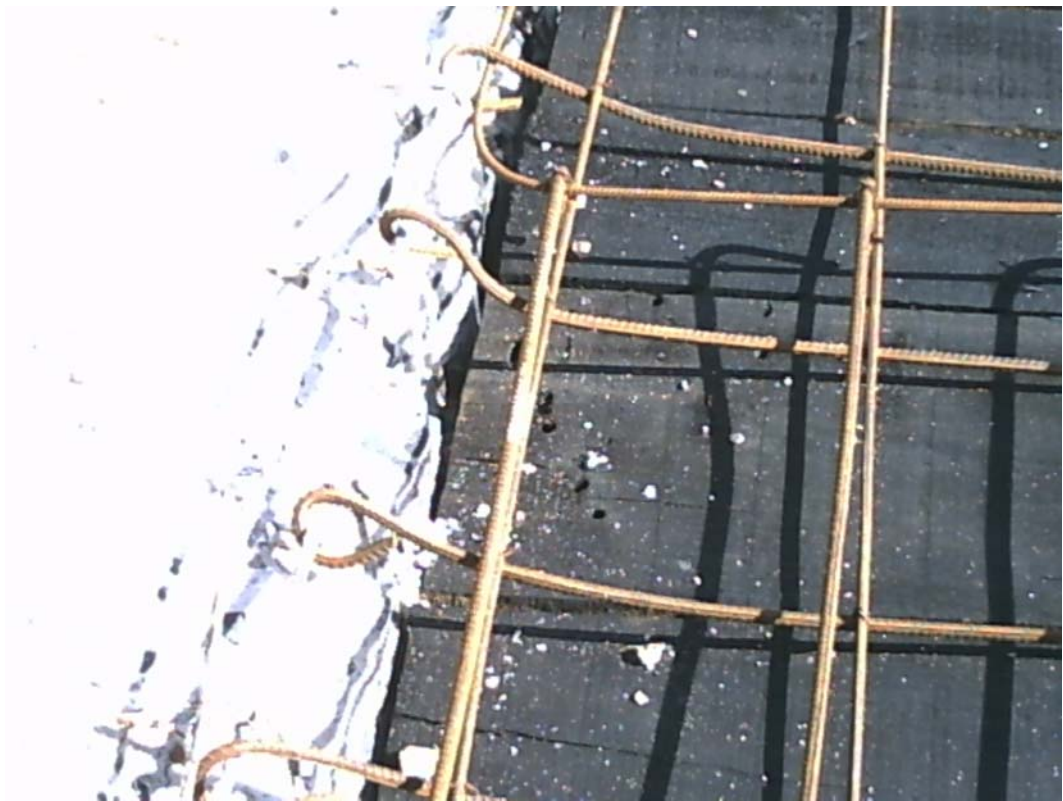
FOTO N° 10: detalle de anclaje de losa nueva con la losa existente en el 2º nivel.
