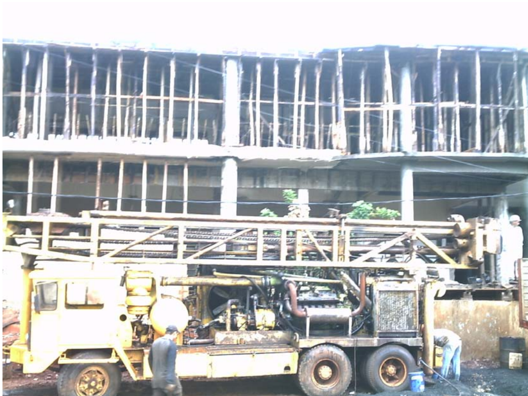
FOTO N° 6: fachada principal de la obra.
