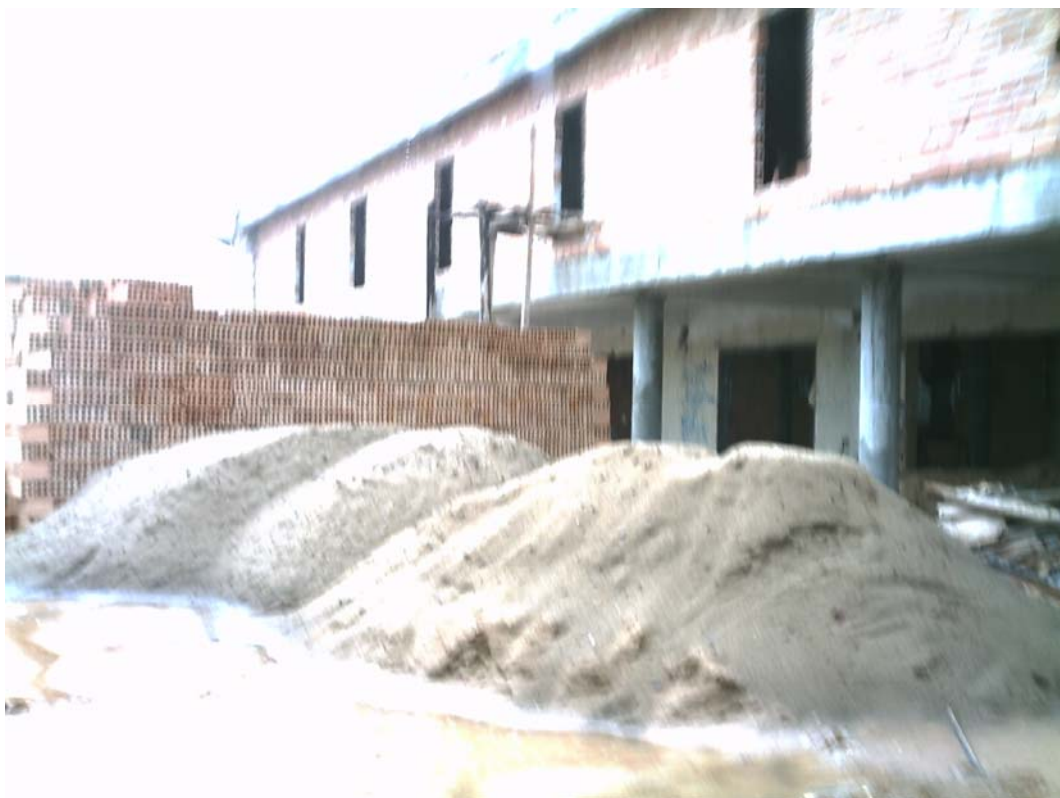
FOTO N° 4: acopio de materiales utilizados en obra.
