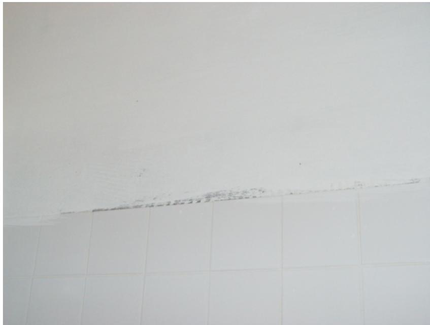
**Foto N° 8. Obra I** Mala terminación de revoque en unión con azulejos.
