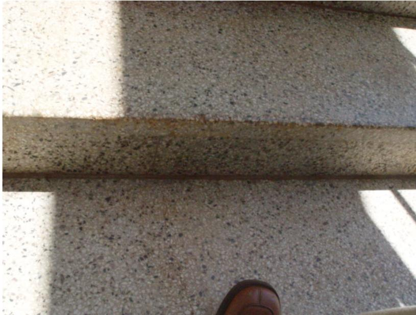
Foto N° 21 y 22. Obra III: Planchas de granito reconstituido, con fisuras.
