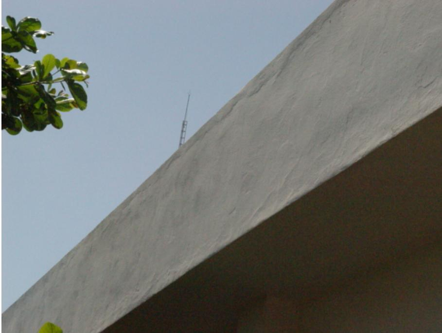
Foto N° 29 y N° 30. Obra VI: revoque externo con superficie con deformaciones. Se acentúa la percepción de la deficiencia en las mochetas con revocolor.
