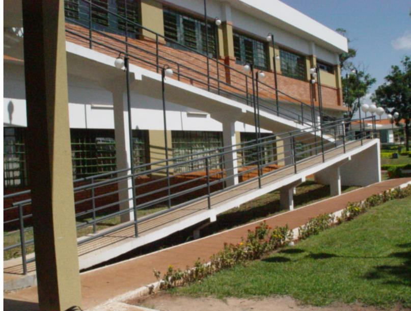
**FOTO N° 13 y N° 14: Construcción de Aulas. Planta Alta Bloque I, ejecutada por la Facultad de Filosofía. La Primera Etapa (Obra III) consistió en las obras básicas (estructura, mampostería, techo, etc.). En la Segunda Etapa (Obra VI) fueron ejecutadas las Terminaciones (piso, pintura, revoque inferior, instalaciones, etc..)**
