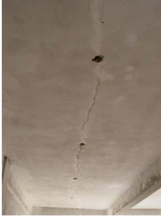
Foto N° 33. Obra V: fisura en losa.
