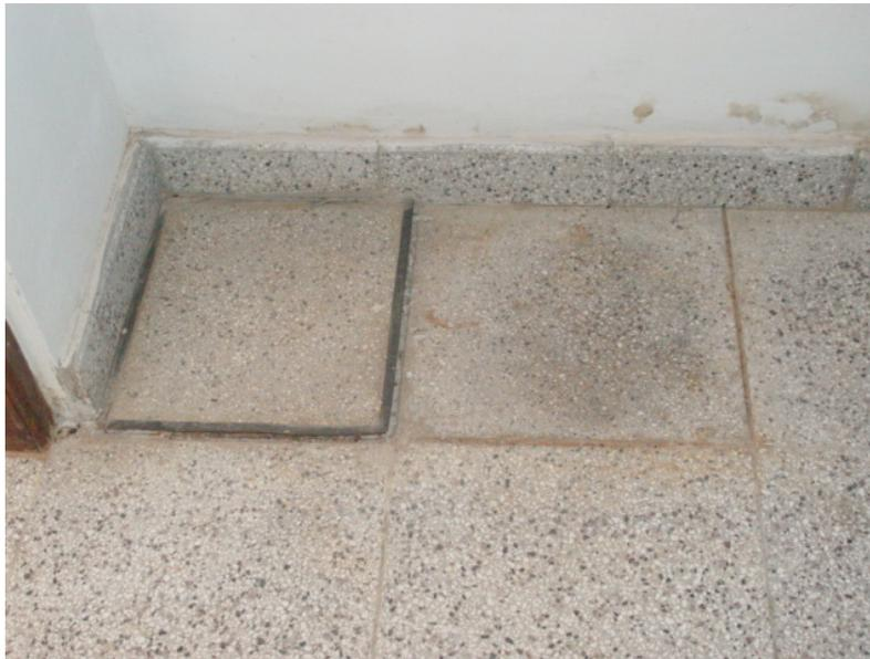
**FOTO N° 18 Obra III: deficiente terminación de piso.**
