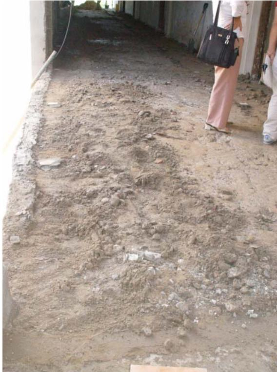
Foto N° 35 y N° 36. Obra V: escombros utilizados en el contrapiso
