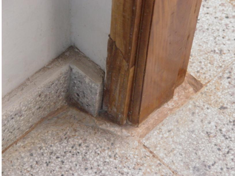
**FOTO N° 19 y N° 20 Obra VI: unión de piso con marco, mal ejecutada. Deficiente colocación del zócalo**
