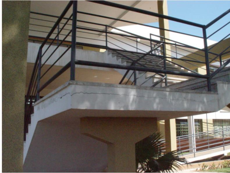
**Foto N° 23 y N° 24. Obra III. Deficiente ejecución de escalera. Desprendimiento de contrapiso y de planchas de granito reconstituido.**
