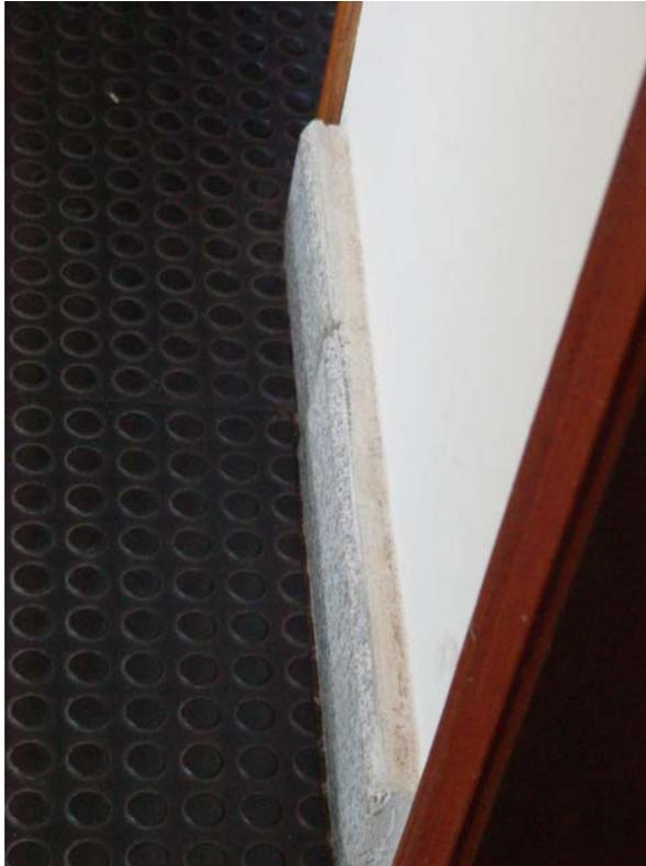
**Foto N° 5. Obra I:** los zócalos de granito reconstituido tienen una colocación no adecuada. Las piezas se dispusieron contra el revoque y no contra la mampostería
