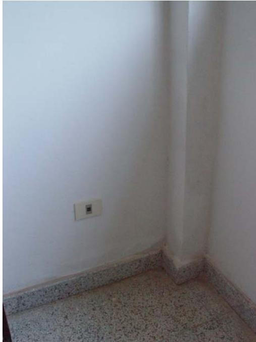
Foto N° 27 y N° 28. Obra VI: Revoque interior con aristas desalineadas
