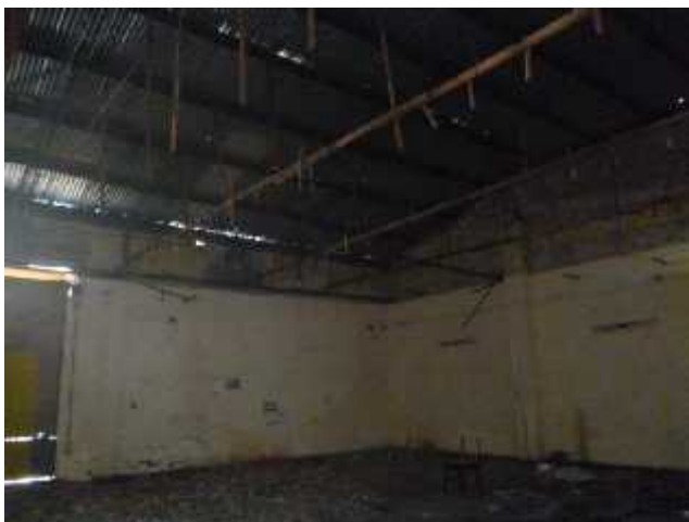
Desmontaje de Cielorraso, inconcluso.
