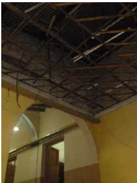
Desmontaje de Cielorraso, inconcluso.
