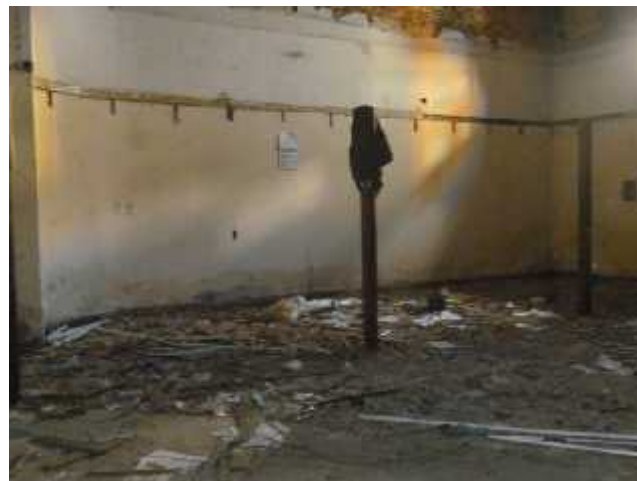
Desmontaje de Entrepiso, inconcluso.
