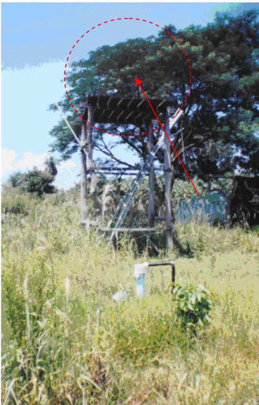
Foto del estado del Sistema de riego: tanque en el suelo y cañerías sueltas. Compañía Pío X. Concepción.
