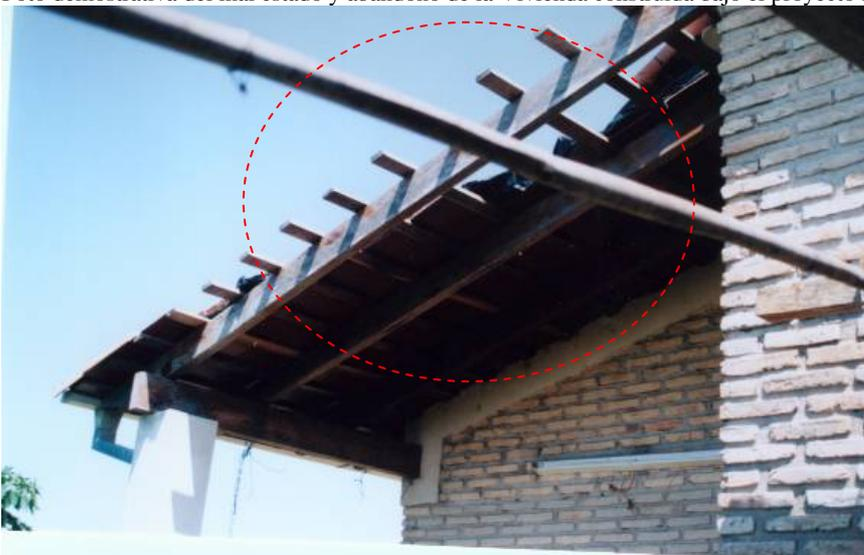
Foto demostrativa del estado de deterioro del techo de una vivienda abandonada. Proyecto Koica. Paso Paredes. Ibycuí
