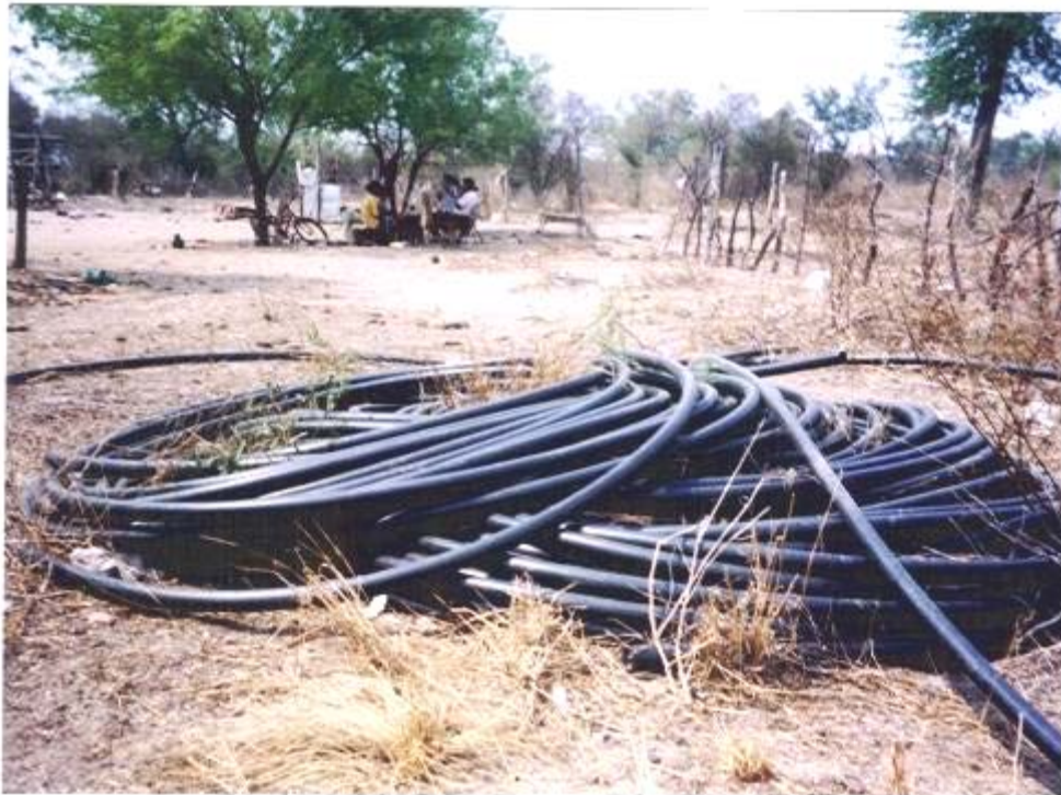
FOTO N° 103 - CAÑOS PLÁSTICOS PVC PROVEÍDO POR PRODECHACO QUE DEBIERON EMPLAZARSE PARA LAS OTRAS CASAS DE LA COMUNIDAD, SE ENCUENTRAN TIRADOS EN EL SUELO A LA INTEMPERIE. APROXIMADAMENTE 200 MT.
