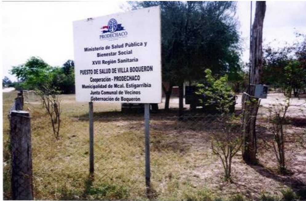
FOTO N° 105 - LETRERO PRODECHACO APORTE PARA CONSTRUCCIÓN, AMOBLAMIENTO Y EQUIPAMIENTO DE PUESTO DE SALUD EN COOPERACIÓN CON MUNICIPALIDAD MCAL. ESTIGARRIBIA, GOBERNACIÓN DE BOQUERÓN Y JUNTA DE VECINOS. ESTA CONSTRUIDO EN UN TERRENO BAJO Y ANEGADIZO, SIN ELEVAMIENTO DEL NIVEL DEL SUELO. ESTE LETRERO SE COSTO A PRODECHACO Gs: 958.000.
