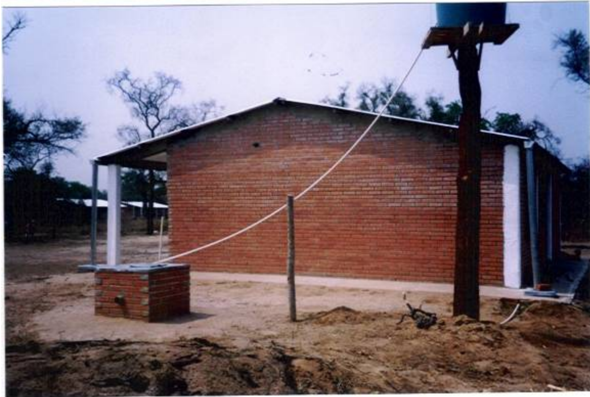
FOTO N° 92 - VISTA LATERAL DE PUESTO DE SALUD SE VISUALIZA EL ALJIBE Y EL CAÑO PARA EL TANQUE. PRODECHACO NO ENTREGO LA MOTOBOMBA QUE ESTABA PREVISTO ENTREGAR, PARA ALZAR AGUA AL TANQUE.
