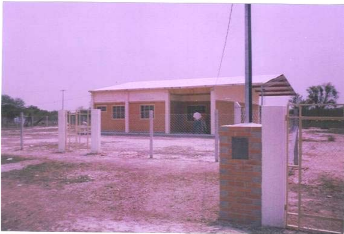
FOTO N° 76 - FOTO EXTERNA FRONTAL DE LA GRAN ESTRUCTURA CONSTRUIDA POR PRODECHACO, PARA LOCAL DE SALUD. SE VISUALIZA POSTES DE HORMIGÓN, ALAMBRE TEJIDO, PORTONES METÁLICOS. ESTA UBICADO EN EL CENTRO MISMO DE PUERTO LA VICTORIA.,
