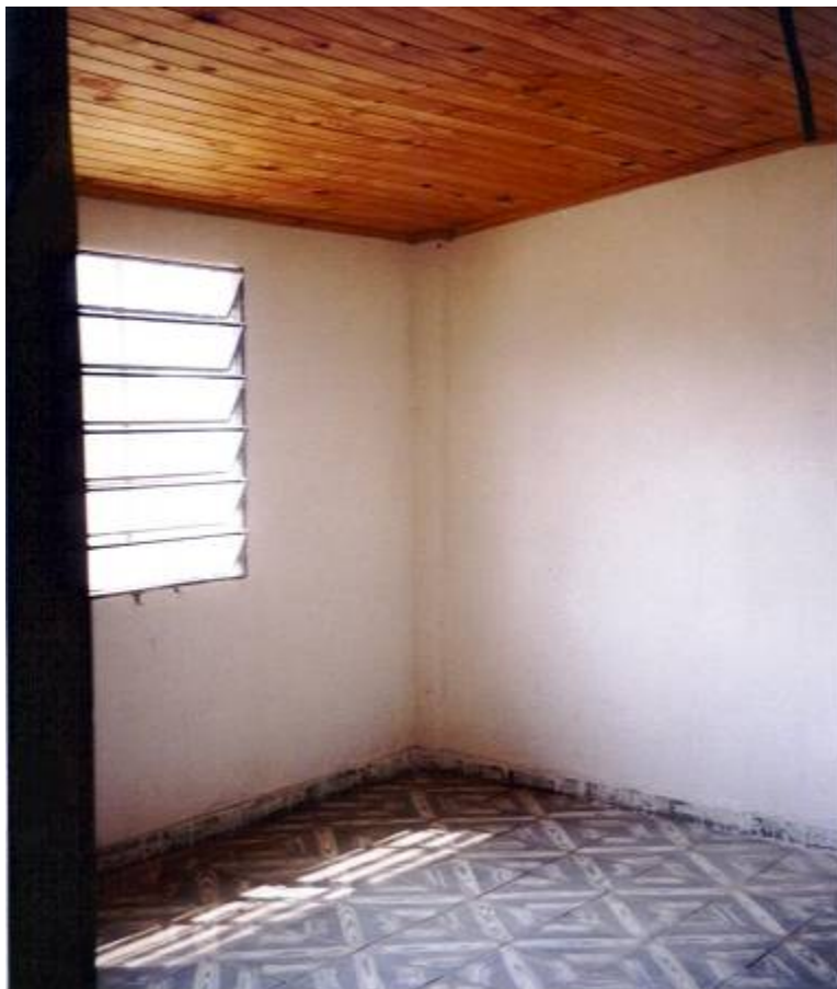
FOTO N° 93 – FOTO DEL INTERIOR DEL PUESTO DE SALUD. SE NOTA EL MACHIMBRE, LA MAMPOSTERÍA, BALANCÍN, PISO (BALDOSAS)
