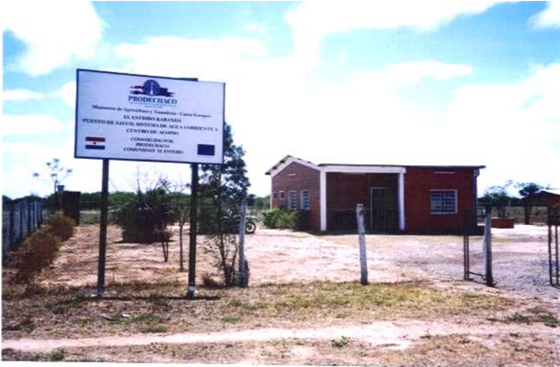
FOTO N° 122 - PUESTO DE SALUD CONSTRUIDO, AMOBLADO Y EQUIPADO POR PRODECHACO. INCLUYE EQUIPO AUTÓNOMO GENERADOR DE CORRIENTE. SE REALIZÓ RELEVAMIENTO DEL EQUIPAMIENTO Y MEDICIONES DE LA ESTRUCTURA
