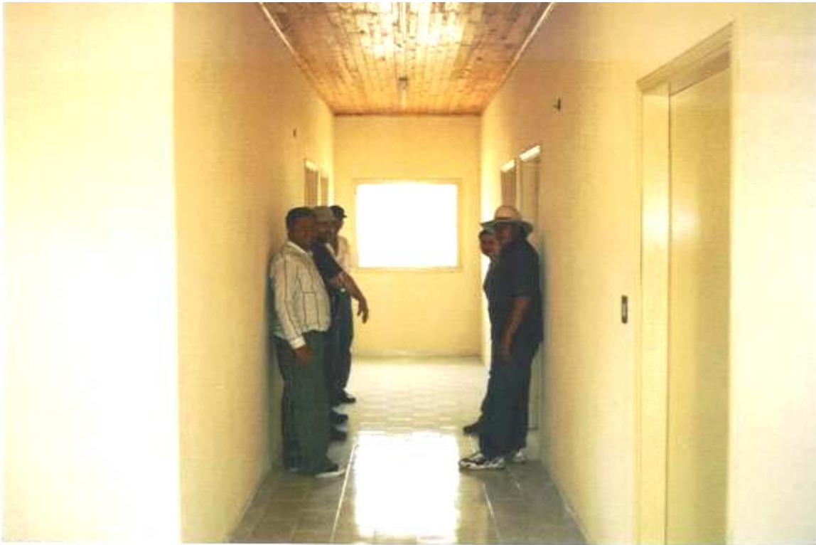
FOTO N° 85 – PASILLO INTERIOR DE LA ESTRUCTURA. NÓTESE EL MACHIMBRE Y BALDOSAS DE PRIMERA
