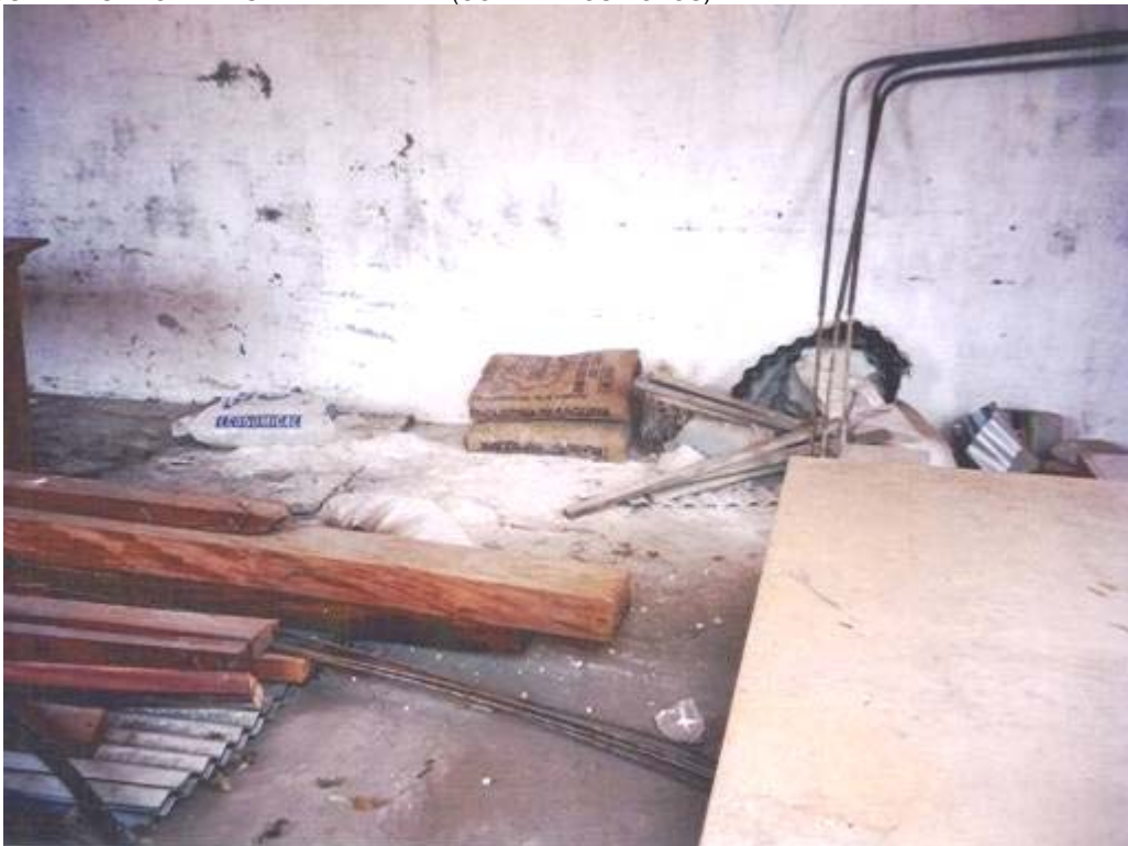
FOTO N° 101 - FOTO DEL INTERIOR DEL LOCAL ESCOLAR. SE OBSERVA PARTES DE LOS MATERIALES RESTANTES QUE PROVEYÓ PRODECHACO. SALDOS DE CEMENTO TIPO ALBAÑIL (SEGÚN COMPROBANTE DE COMPRA EL CEMENTO DEBIÓ SER TIPO 1).
