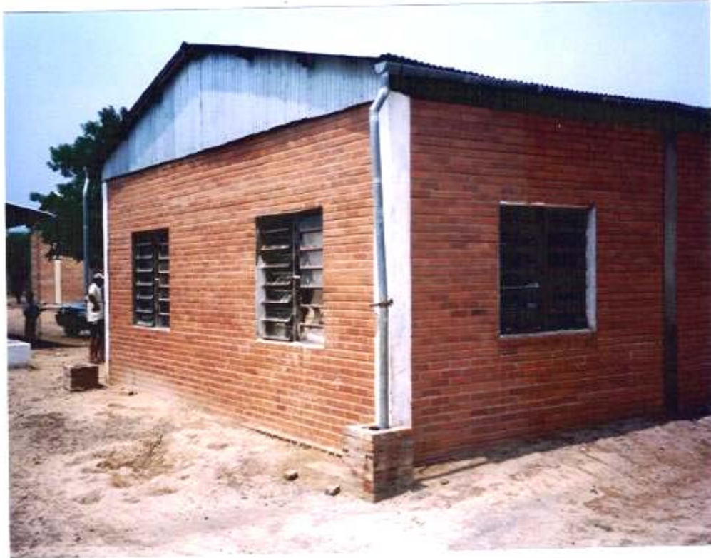
FOTO N° 100 - ESCUELA ASISTIDA POR PRODECHACO CON LOS MATERIALES PARA LA MAMPOSTERÍA DE UN AULA. EL TINGLADO ES PRE-EXISTENTE. NO SE PUEDE INGRESAR AL AULA DEBIDO A QUE LA PERSONA QUE TIENE LA LLAVE NO SE ENCUENTRA, SE REALIZA MEDICIONES DESDE EL EXTERIOR. LA FOTO SIGUIENTE SE TOMA DESDE LA VENTANA (CON VIDRIOS ROTOS)
