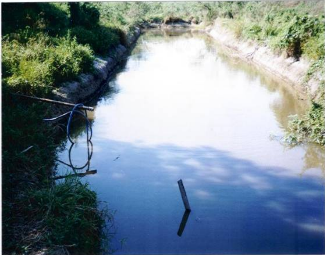
FOTO N° 70 – AL FONDO DE LA HUERTA, SE ENCUENTRA UN TAJAMAR DEL CUAL SE SURTE DE AGUA PARA EL RIEGO. AL MOMENTO DE LA VISITA LA TOMA DE SUCCIÓN ESTA FUERA DEL AGUA DEBIDO A QUE NO SE ESTA REGANDO LA HUERTA DEBIDO AL BAJO NIVEL DEL AGUA, POR LO QUE LA COMUNIDAD RESERVA SOLO PARA CONSUMO.
