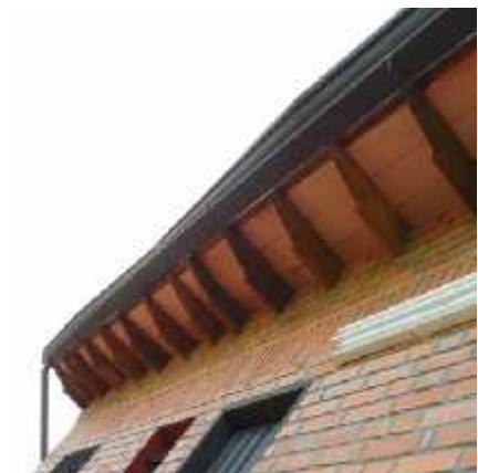
Canaletas con deformación.
