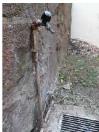
Cañerías expuestas y pérdida de agua en las canillas exteriores.
