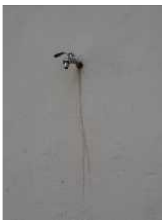
Cañerías expuestas y pérdida de agua en las canillas exteriores.
