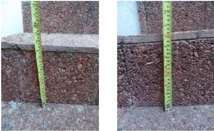
Contrahuellas de los escalones de la escalera de patio posterior.
