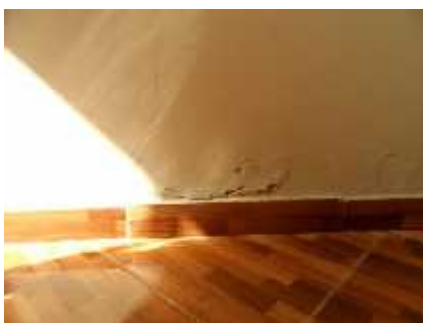
Deficiente aislación de muros.
