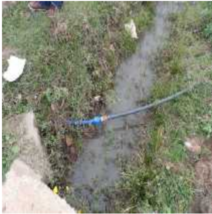
Instalación expuesta y con pérdidas.
