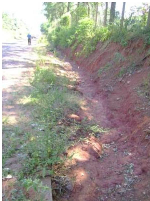
**FOTO N° 2:** Malezas invadiendo la calzada y la zanja de drenaje excavada.
