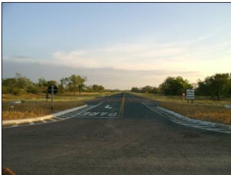
FOTO N° 13: INICIO DEL TRAMO – SECCION I
