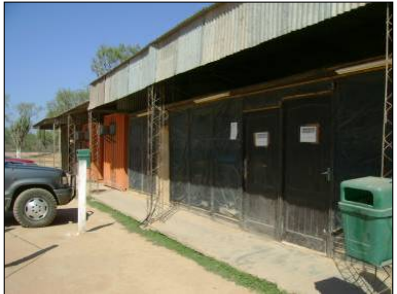
FOTO N° 8: INSTALACIONES PARA LA FISCALIZACION – OFICINA, COCINA Y DORMITORIOS
