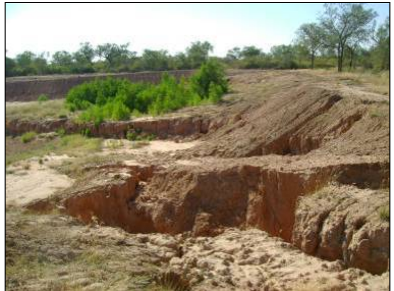
FOTOS N° 17 y 18: AREAS DE PRÉSTAMOS, TALUDES EROSIONADOS, SIN CONFORMACIÓN.
