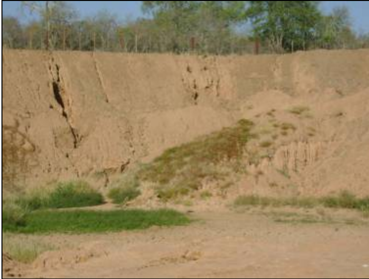
FOTOS N° 17 y 18: AREAS DE PRÉSTAMOS, TALUDES EROSIONADOS, SIN CONFORMACIÓN.
