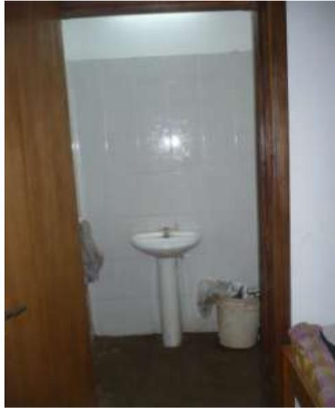
Obra: Construcción de un Puesto de Salud en la Comunidad Indígena Pesempo'o, en los baños los pisos son de alisada de cemento, sin la debida aislación correspondiente.
