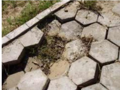
Adoquines sueltos y hundidos, falta una adecuada compactación, sin cordón de contención al final del tramo.
