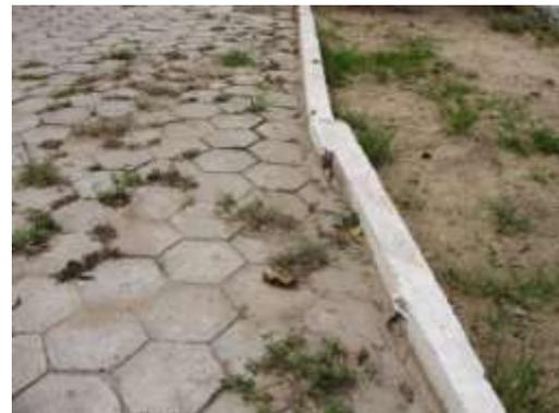
Vista General del tramo, con pasto crecido en varios sectores, los adoquines sueltos y hundidos en varios tramos, falta de adecuada compactación, cordones de hormigón rotos.
