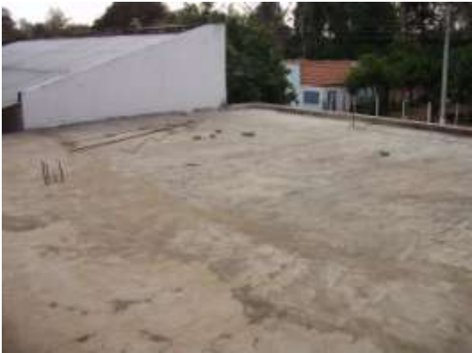
Vista de la losa de HºAº
