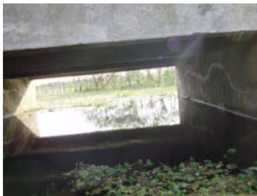
Vista del Puente de HºAº
