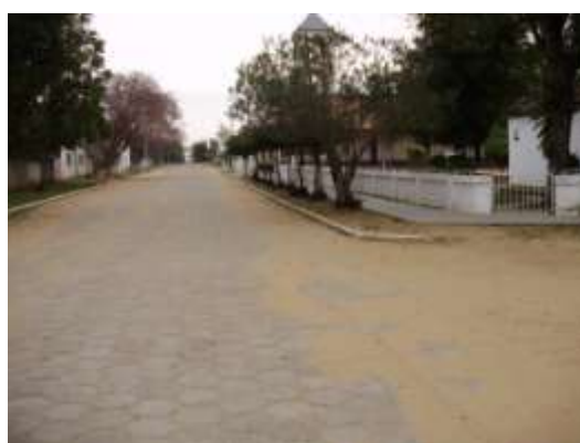
Vista General del adoquinado
