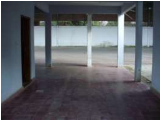
Vista interior de la ampliación, área de cochera
