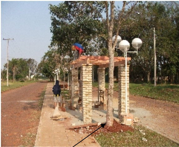
Construcción de Pérgola en el Paseo central de la Avda. Rivas desde las Residentas hasta Cacique Canindeyú.
