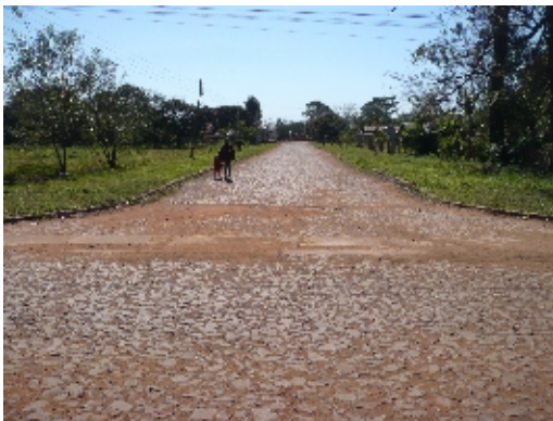
Empedrado sobre calle Huasipungo sin cartel obras.
