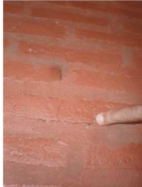
En las mamposterías de elevación, construidas con ladrillos comunes, el espesor de las juntas son superiores a 1,5 cm.
