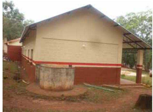
Techo sin canaletas, bajadas, canales de desagüe, ni rejillas
