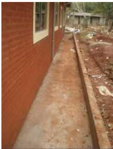
Sin canal de desagüe pluvial, ni rejillas
