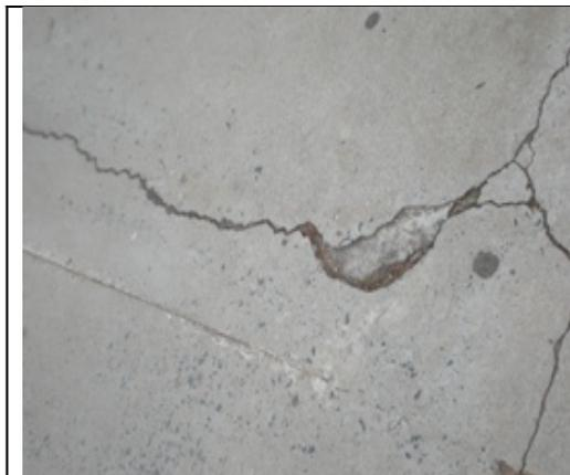
En el sector de la ciclovía como de la pista de juegos, se observan fisuras en el hormigón por vicios de construcción. No se pudo constatar que la superficie sea de hormigón armado.
