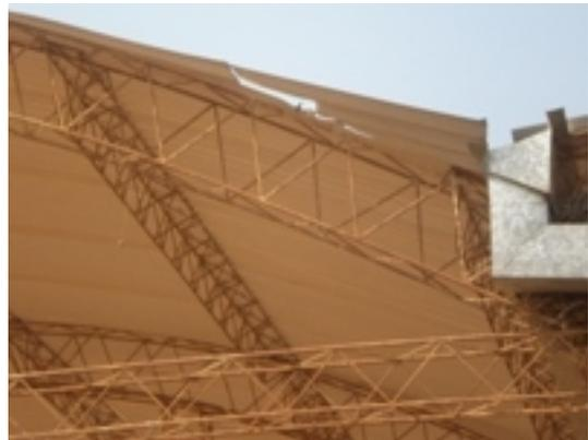
Se observa la utilización de materiales que no responden efectivamente al trabajo al que están sometidos, varillas deformadas y la cobertura de chapa deteriorada, que se encuentra expuesta a la incidencia de fuertes vientos, propios del lugar donde se encuentra implantada.
