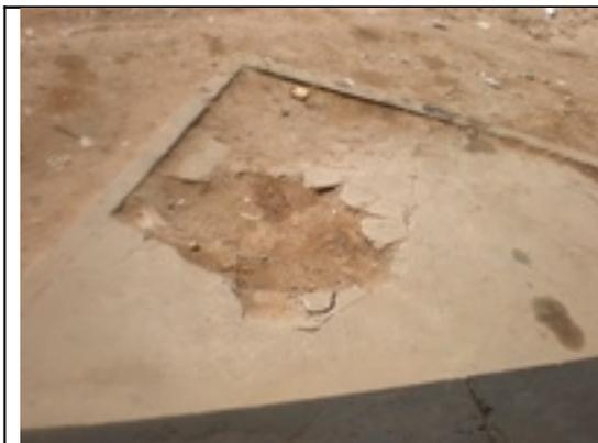
En el patio posterior de la Terminal, el piso exterior de hormigón, sector donde aparcen los ómnibus, se encuentra asentado directamente en el suelo natural, con un espesor mínimo de 2 cm. y sin una base correspondiente, por lo que se encuentra en total deterioro.
