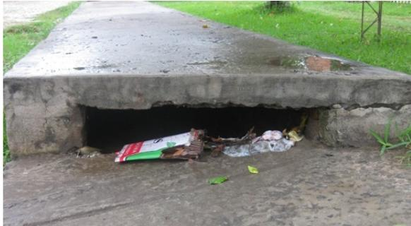
El canal de agua es interrumpido en su desarrollo longitudinal por las rampas de acceso vehicular, y la acumulación de residuos en los espacios apreciados en la imagen, ocasionan el entorpecimiento del paso de agua, produciendo la acumulación de la misma en días de fuertes lluvias.
