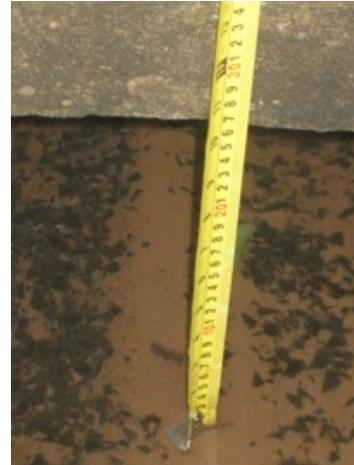
Vista del canal, mostrándose la insuficiente altura útil del canal.
