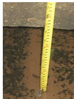
Vista del canal, mostrándose la insuficiente altura útil del canal.
