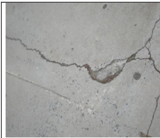
En el sector de la ciclovía como de la pista de juegos, se observan fisuras en el hormigón por vicios de construcción. No se pudo constatar que la superficie sea de hormigón armado.
