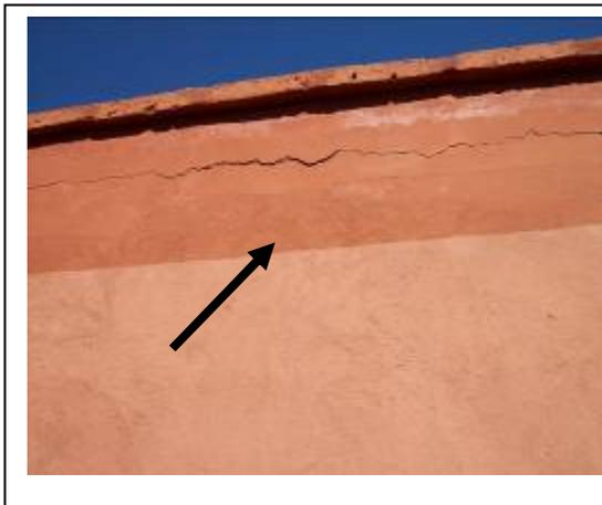
El depósito PROAN, a menos de 1 (un) año de haber sido construido, presenta fisuras en las paredes (exterior) como así también goteras.
