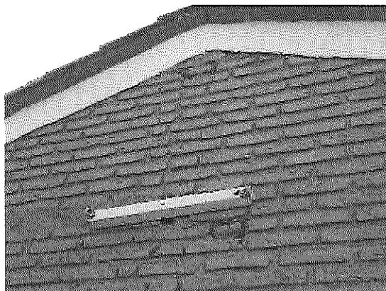
Deficiencias en la construcción de mampostería: ladrillos sueltos y juntas irregulares.
