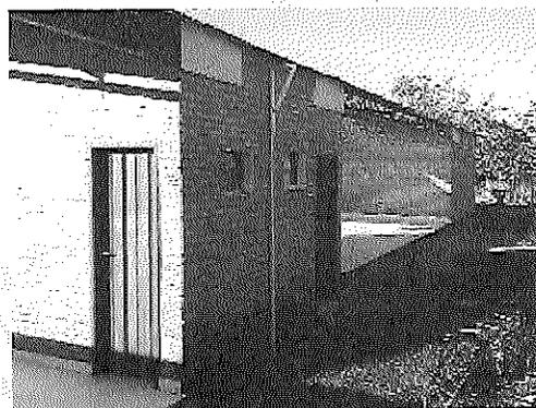
Mancha de humedad en las paredes, por falta de tratamiento hidrófugo.
