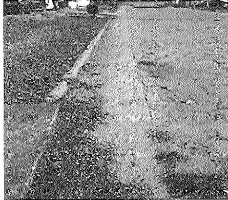
Hundimiento de adoquín y rotura de canaleta de Hormigón.
