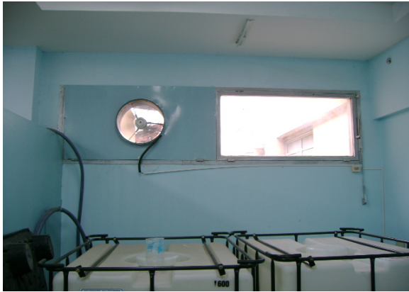
Depósito estrecho con poca ventilación.
