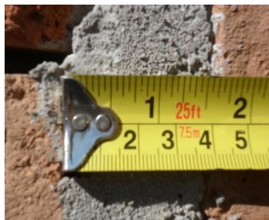
Foto 2: Los ladrillos fueron asentados con un enlace mayor que la mitad de su ancho, en todos los sentidos.
