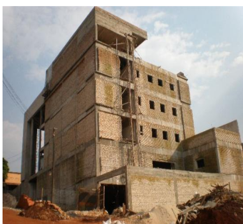
Foto 6: Se verifica en los cerramientos, especialmente hacia el sector Este, la presencia de humedad caracterizada notoriamente por el moho que se observa. (ver también fotos Nos. 1 y 5).
