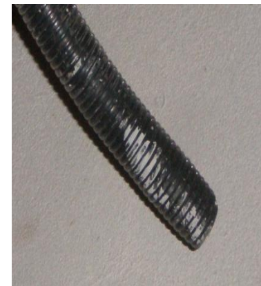
Foto 2: Canalizaciones para las distribuciones y alimentaciones instaladas no corresponden a las establecidas en las EETT que dicen: "se usarán Tuberías PVC antillama, en caso de ir al aire libre"
