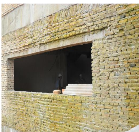
Foto 5: El espesor de los lechos de mortero, exceden los 10 mm; Las paredes se ejecutaron con varios tipos de ladrillos, sin color uniforme, con medidas diferentes, grietas, cavernas y núcleos calcáreos. Se observa que los cerramientos hacia el sector Este, presentan ataque de moho.
