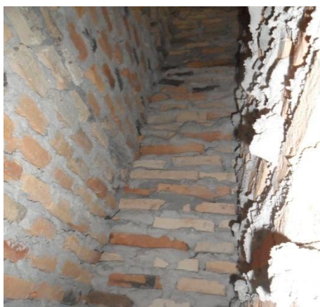
Foto 4: Se utilizaron medio ladrillo, en varios sectores; La trabazón no fue regular, las llagas no se corresponden según líneas verticales.
