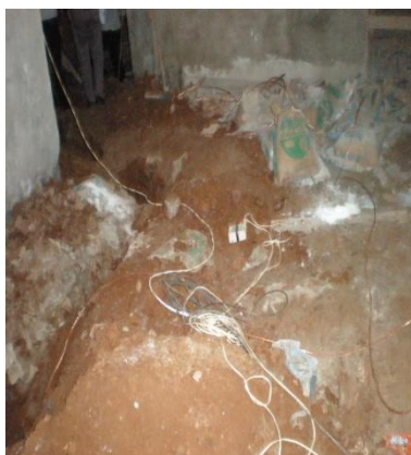
Foto1: conductor de cobre diámetro menor a lo establecido en las EETT
