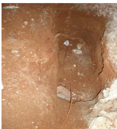
Foto1: conductor de cobre diámetro menor a lo establecido en las EETT
