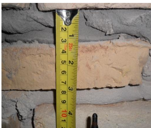
Foto 2: Los ladrillos fueron asentados con un enlace mayor que la mitad de su ancho, en todos los sentidos.
