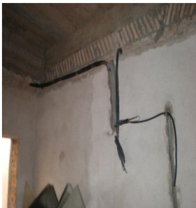
Foto 2: Canalizaciones para las distribuciones y alimentaciones instaladas no corresponden a las establecidas en las EETT que dicen: "se usarán Tuberías PVC antillama, en caso de ir al aire libre"
