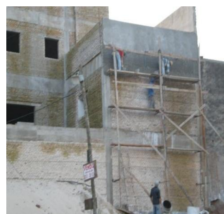
Foto 6: Se verifica en los cerramientos, especialmente hacia el sector Este, la presencia de humedad caracterizada notoriamente por el moho que se observa. (ver también fotos Nos. 1 y 5).
