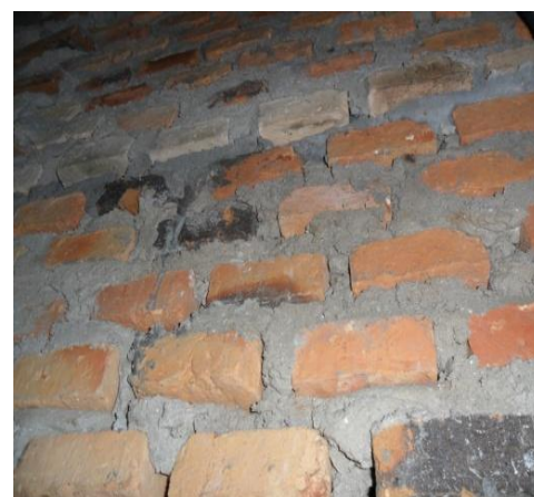
Foto 5: El espesor de los lechos de mortero, exceden los 10 mm; Las paredes se ejecutaron con varios tipos de ladrillos, sin color uniforme, con medidas diferentes, grietas, cavernas y núcleos calcáreos. Se observa que los cerramientos hacia el sector Este, presentan ataque de moho.
