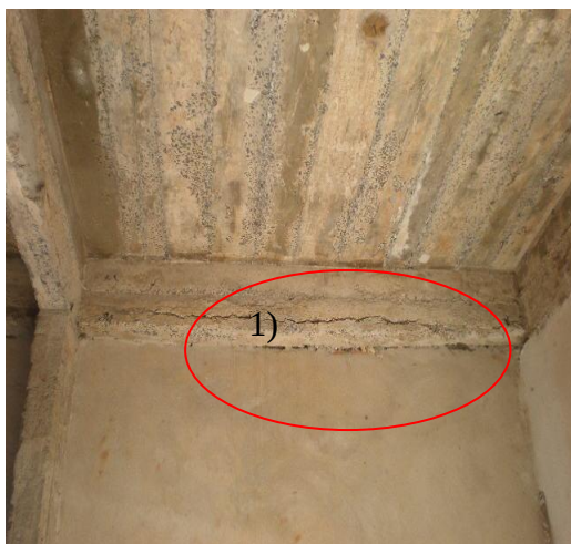
Foto 1: se observa la línea de desprendimiento a lo largo de la viga V5 tramo b, segregación en fondo de losa L3.
