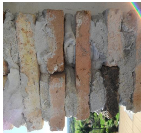
Foto 4: Se utilizaron medio ladrillo, en varios sectores; La trabazón no fue regular, las llagas no se corresponden según líneas verticales.
