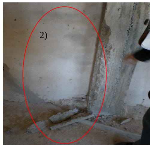
Foto 1: se observa la línea de desprendimiento a lo largo de la viga V5 tramo b, segregación en fondo de losa L3.
