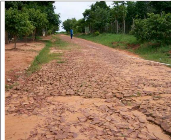
Foto 7 – Asentamiento y juntas abiertas debido a la acción de las aguas de lluvias.
