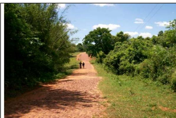
Foto 13 - Se observa la invasión de pastos cubriendo gran parte del pavimento y también las juntas que de a poco van quedando vacías del material de relleno.
