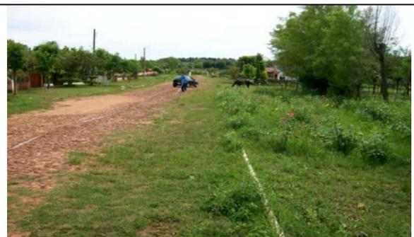
Foto 2 - Pastos y malezas invadiendo gran parte del pavimento por falta de mantenimiento.
