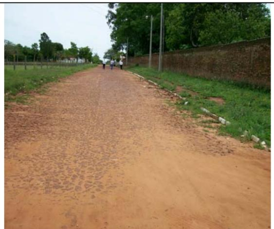
Foto 10 - Juntas de relleno erosionado y pastos que empiezan a crecer en los intersticios.
