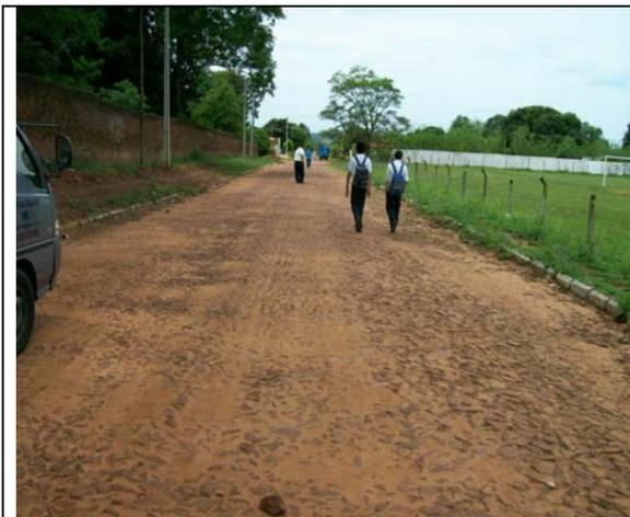
Foto 9 -Se observa las juntas abiertas debido a la acción de las lluvias que arrastran el material de relleno.
