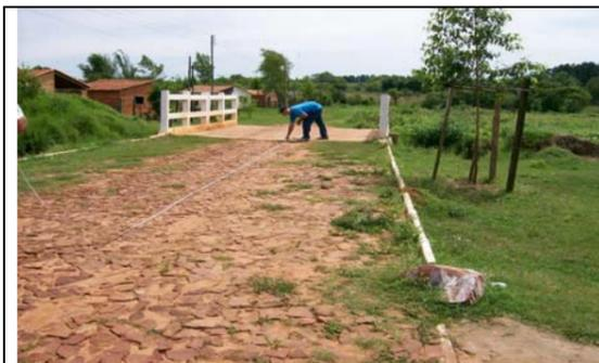
Foto 1 - Juntas abiertas a consecuencia de la acción erosiva del agua que en el futuro conducirá al desprendimiento de las piedras.
