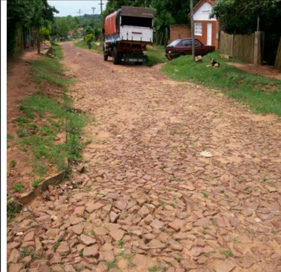
Foto 3 - Juntas abiertas debido a la acción de las lluvias que arrastran el material de relleno ya que la misma es solo de tierra
