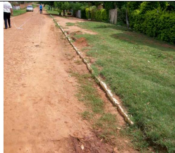
Foto 6 – Falta de cordón al inicio del empedrado, e inicio de deterioro en el empedrado, debido a la falta de confinamiento.
