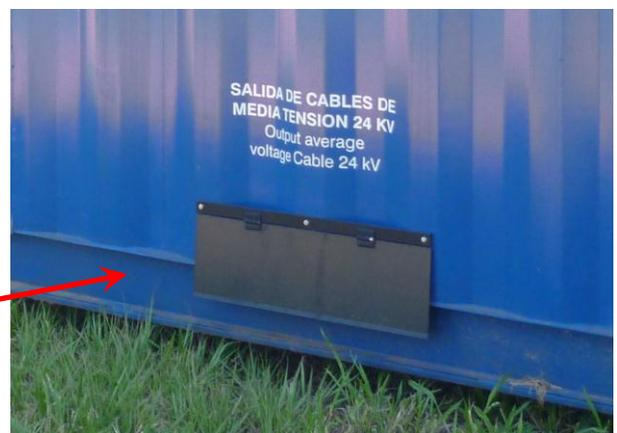
**2.1.2** La cabina de los contenedores no cuentan con extractores de aire, incumpliendo la Especificación Técnica SGT/IM/02-B/2010 que establece en el numeral 3.5: *"La cabina deberá contar con extractores de aire caliente del ambiente para mantener una temperatura ideal de funcionamiento, accionados por un termostato y/o en forma manual"*.
