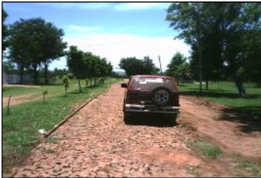
**El ancho de 3.5 m. por calzada no es suficiente para 2 vehículos**
