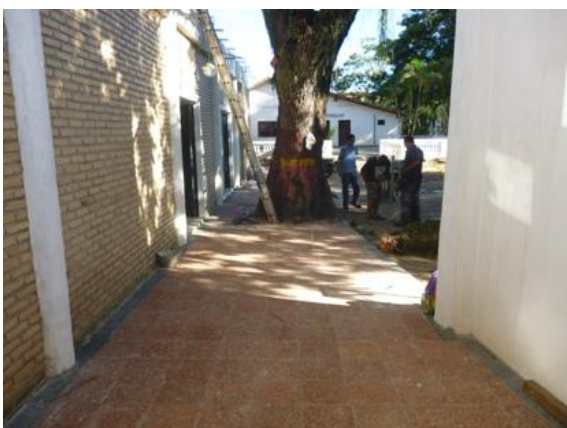
GALERÍA DE ACCESOS A TALLERES
