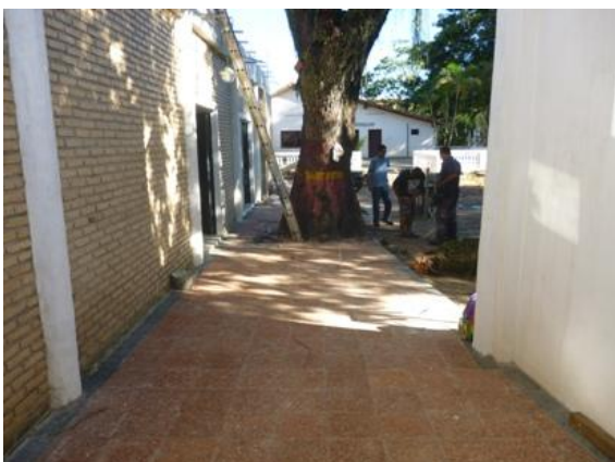
GALERÍA DE ACCESOS A TALLERES
