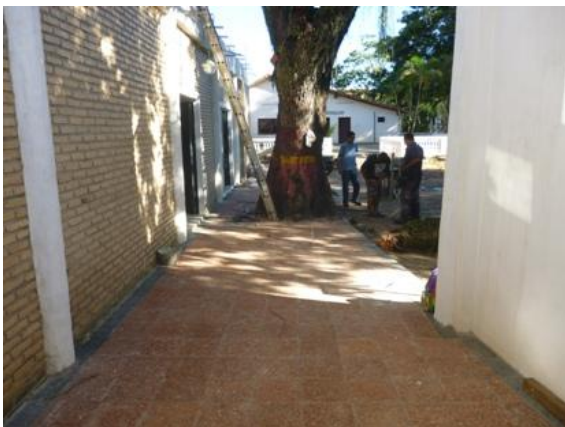
GALERÍA DE ACCESOS A TALLERES
