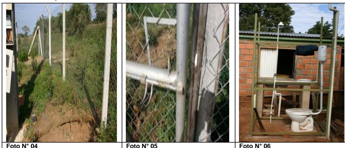
Foto N° 04: Terreno erosionado porque no se encuentra nivelado ni compactado.
