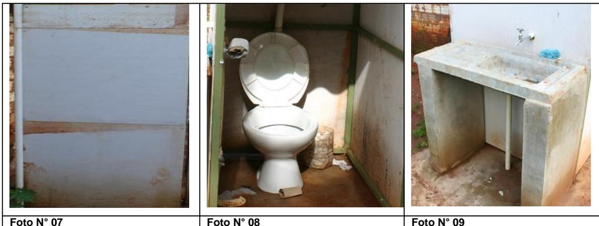
Foto N° 07: Las paredes de fibrocemento están colocados en varios pedazos.
