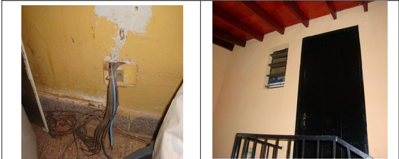
Cables sueltos dentro del depósito
