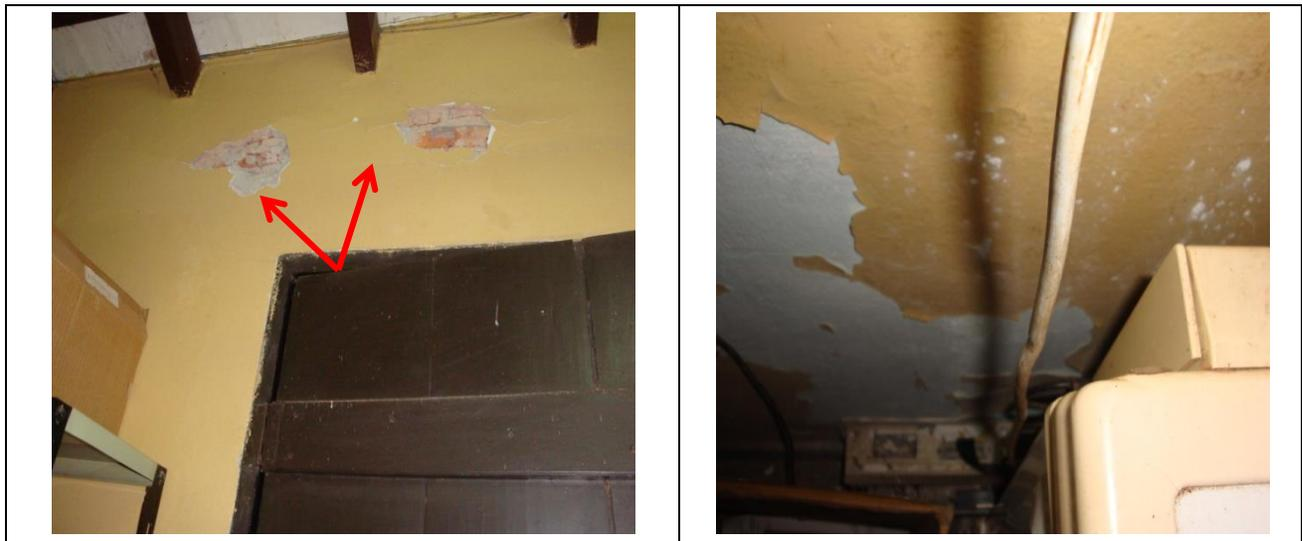
Paredes con fisuras y pinturas descascaradas
