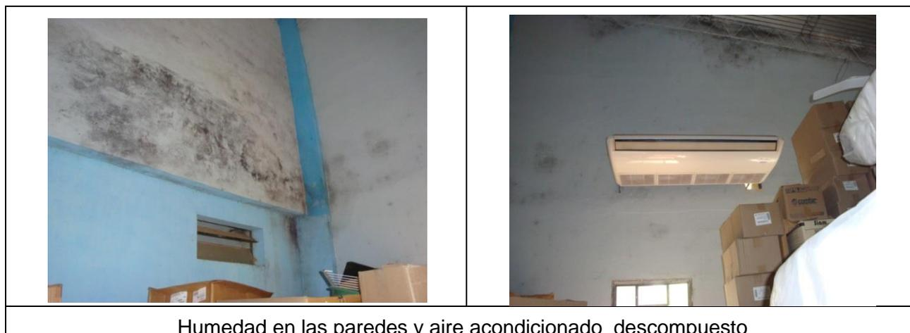
Humedad en las paredes y aire acondicionado descompuesto
