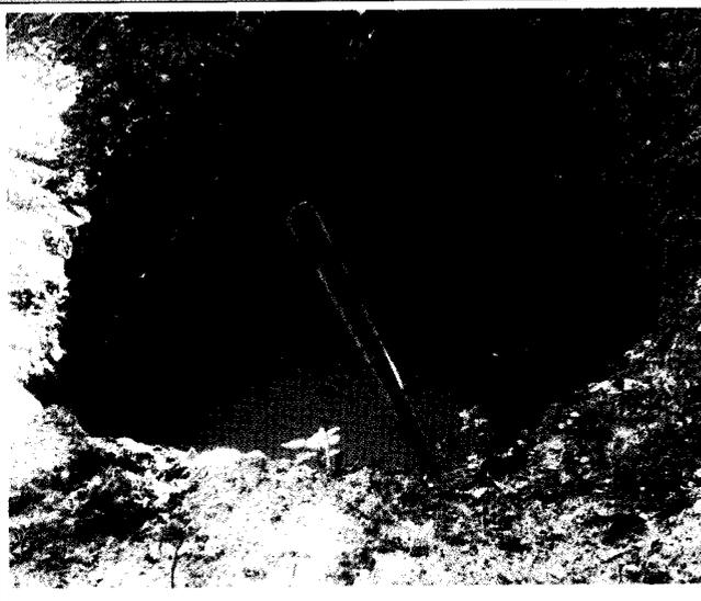
Foto N° 117: Fosa sanitaria cavada sin trabajos de albañilería
