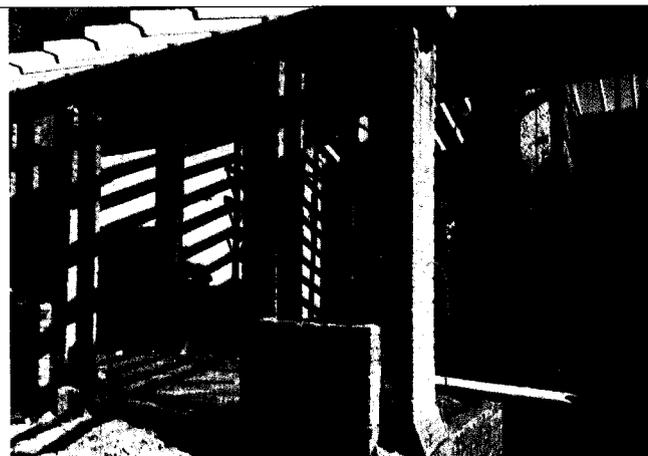
Foto N° 60: Sin trabajos de revoque, contrapisos, electricidad, plomería
