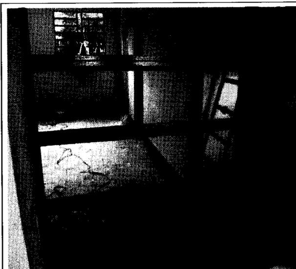
Foto N° 132: Falta colocación de vidrios
