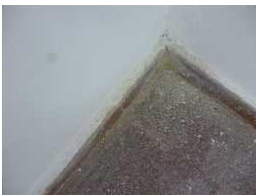
Unión entre muro y zócalo, no uniforme.
