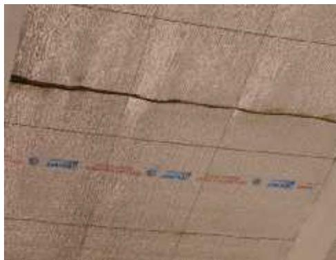
Membranas termo-acústicas, con deficiente colocación.
