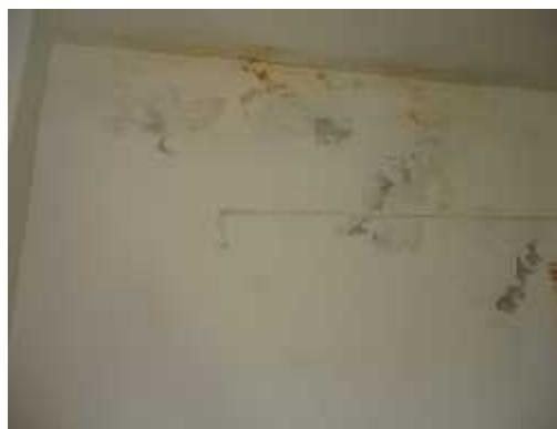
*Humedad y filtración en los muros.*
