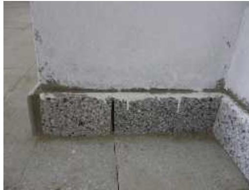
Pisos con remiendos y mezcla de asiento de los zócalos no uniforme.
