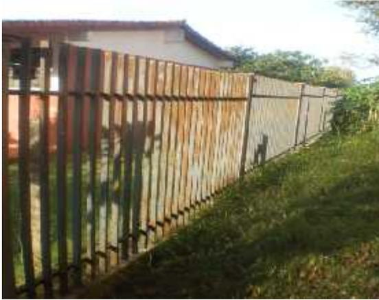
10.-Cercado metálico sin pintura sintética conforme a planilla de oferta y EE.TT.
