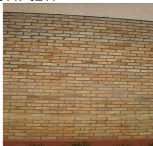
*Ladrillos vistos no seleccionados con disparidad de colores y falta de limpieza antes de la pintura siliconada.*
