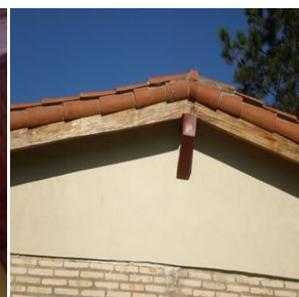
*Maderamen de techo y cielorraso con alburas, nudos, cepillado y pintura insuficiente. La sujeción entre tirantes no cuentan con planchuelas metálicas.*
