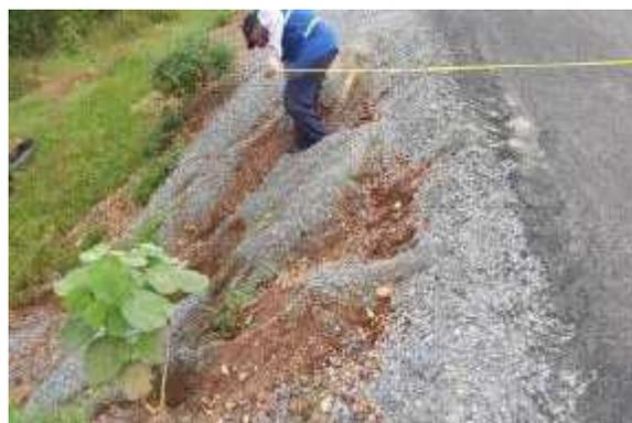
ATS taponada, a la derecha, talud y banquetas c/desprendimientos por la erosión.
