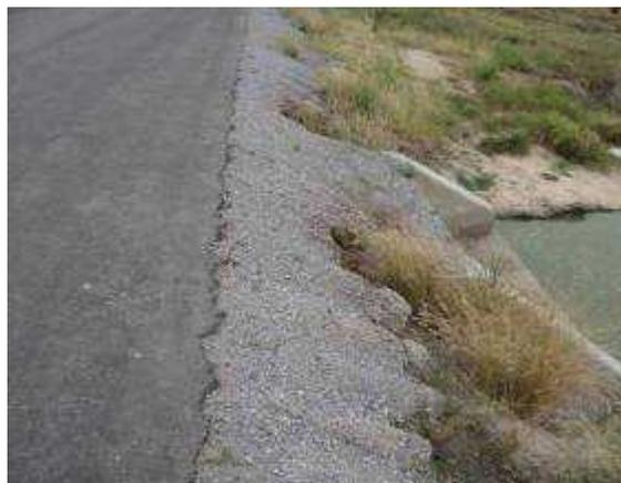
Erosión de taludes
