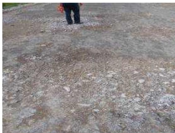
Deterioro de imprimación de base granular
