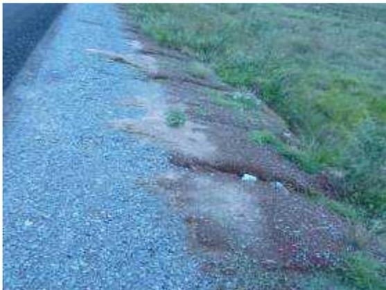
Erosiones en taludes
