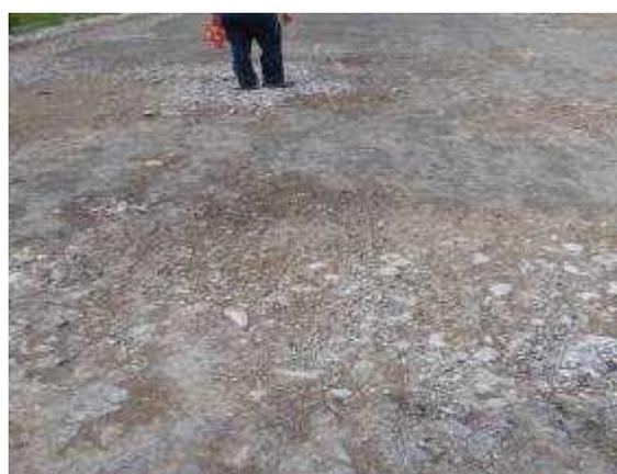
Deterioro de imprimación de base granular
