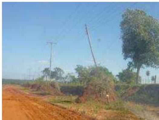
Se observan los montículos que soportan precariamente las columnas del tendido eléctrico.
