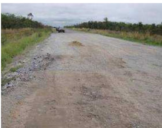
Base granular con imprimación deteriorada
