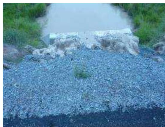
Erosiones talud sobre ATD
