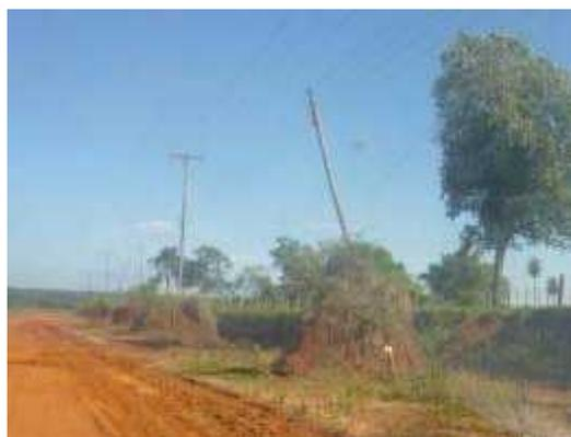
Se observan los montículos que soportan precariamente las columnas del tendido eléctrico.
