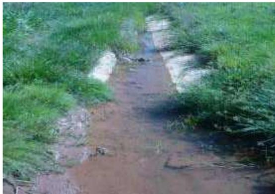
Cuneta revestida lateral entupida y c/agua
