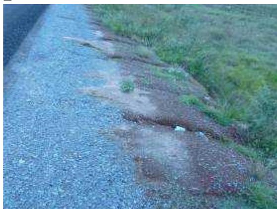
Erosiones en taludes
