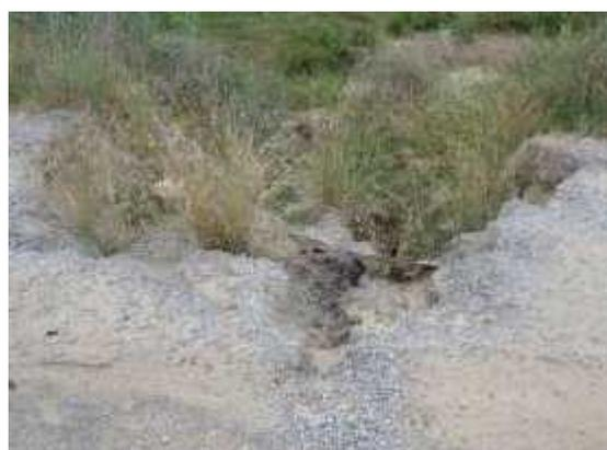
Erosión de calzada y talud por suelo dispersivo
