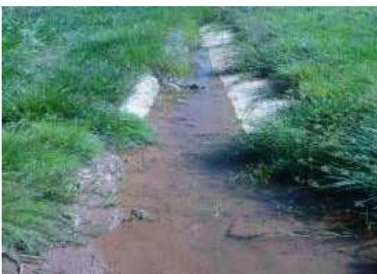
Cuneta revestida lateral entupida y c/agua
