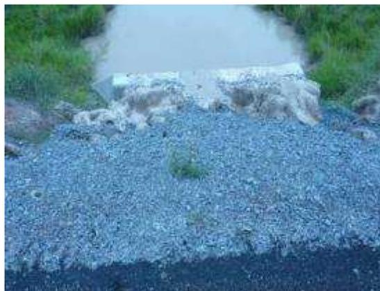
Erosiones talud sobre ATD
