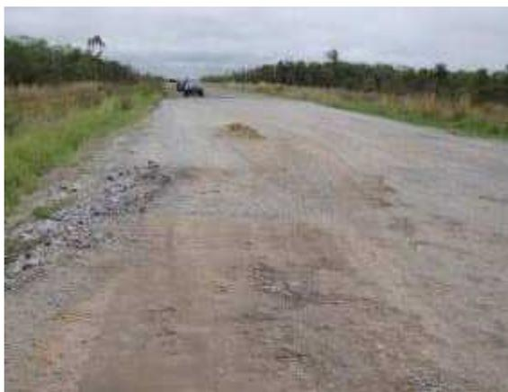
Base granular con imprimación deteriorada
